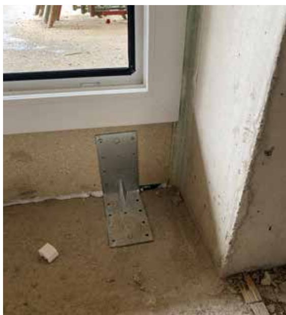
Vijačenje purenita v tla
