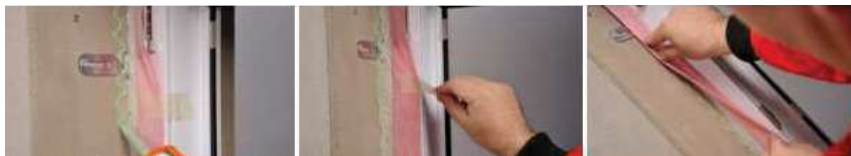
Nanašanje lepila na gradbeni element in lepljenje folije
