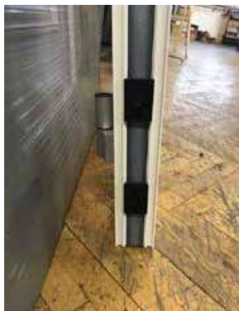
Ploščici pri spodnjem tečaju
