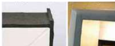
Lepenje predkomprimiranega traku na vogalu okenskega okvirja
