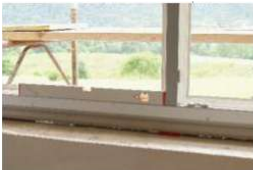
Namestitev okna v okensko odprtino
