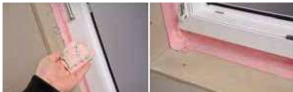
Pri lepljenju folij v vogalih si lahko pomagamo s še dodatnim koncem folije.
